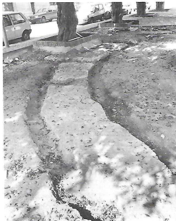
Fig. 26. - Edificio circolare. Particolare delle fondazioni.
